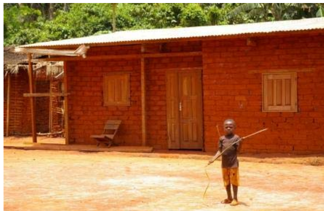
Photo : Réalisation d'une case d'habitation
